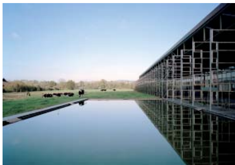
07 Erweiterung der Fensterfabrik G. Baumgartner, Hagedorn
