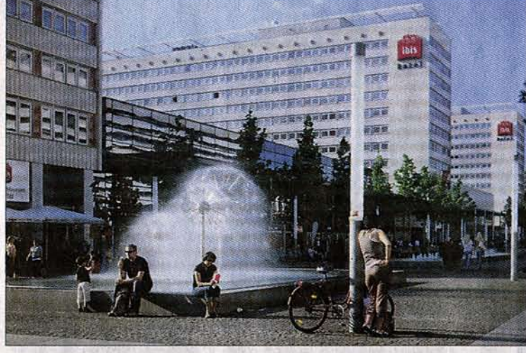
Unwirtlich? Einerseits ja. Aber Hochhäuser wie die an der Prager Straße in Dresden stehen auch für Wohnerechtigkeit. Foto: Felix-Sören Meyer
